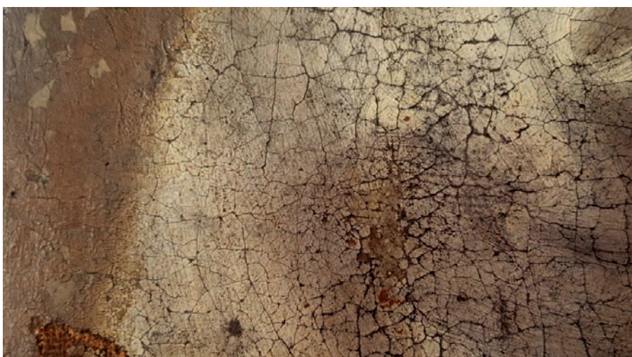
Figura 15: Sarcitura dello strappo e riadesione dei supporti.
