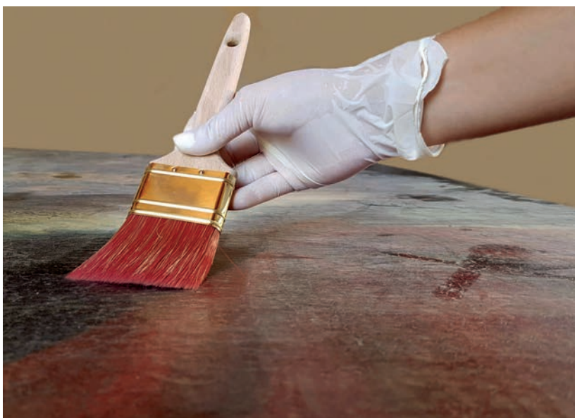
Figura 13: Rimozione dei depositi superficiali incoerenti.
