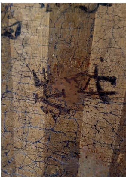
Figura 6: Ridipinture di un precedente intervento di restauro.
